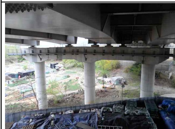
교각 P3 전경
