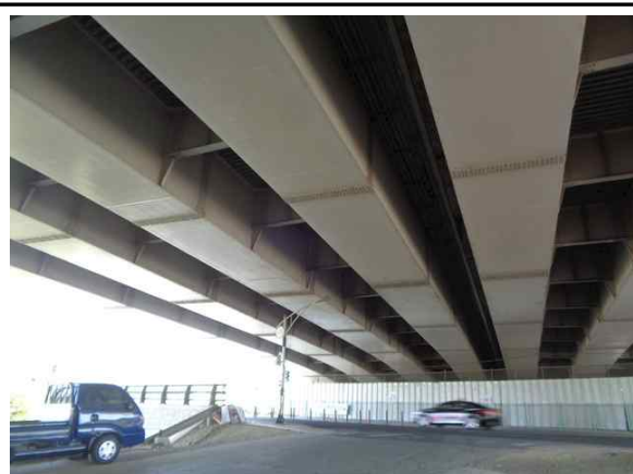
거더 외부(S2) 전경
