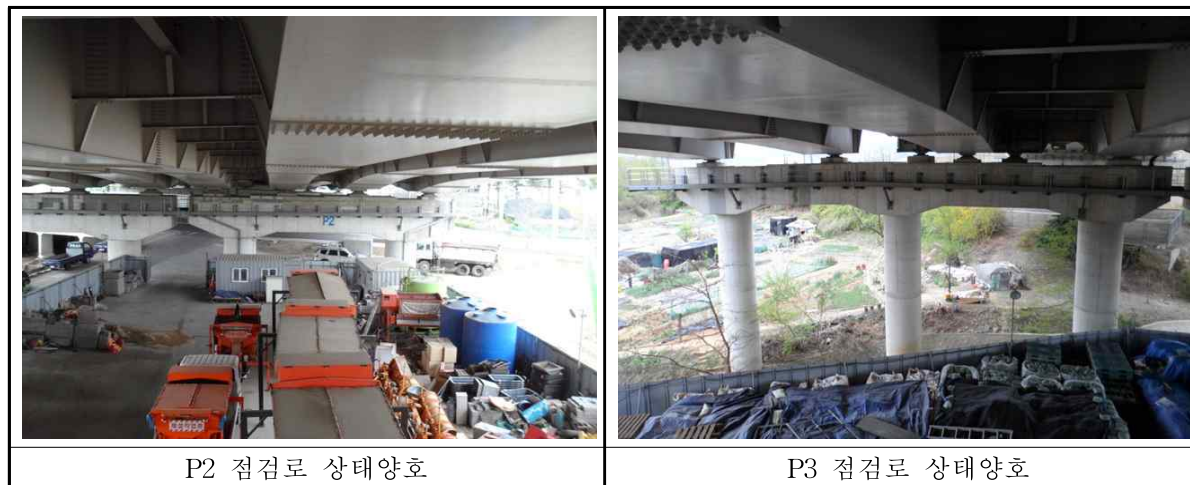
<표 3.28> 범물방향 점검시설 외관조사 결과
