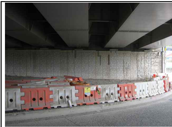
교대 A1 전경
