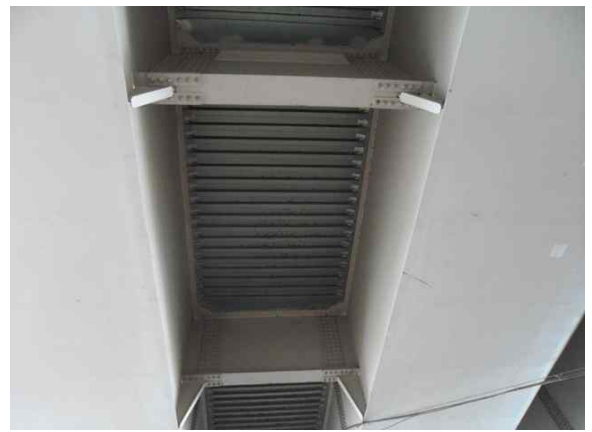
바닥판하면 데크플레이트 전경
