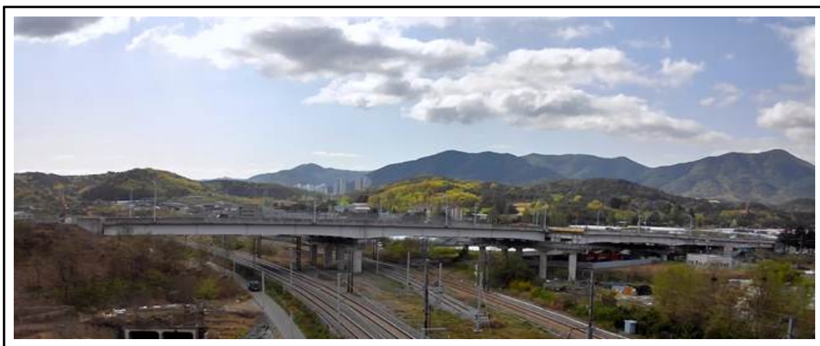
<그림 3.1> 가천교 측면 전경
