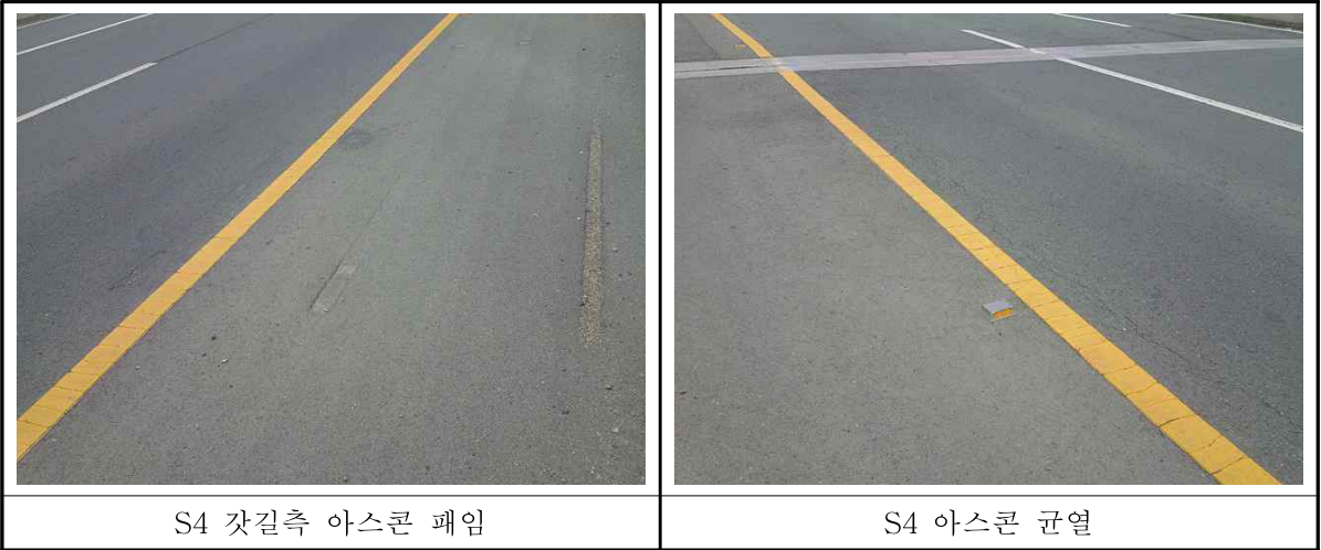
<표 3.22> 범물방향 교면포장 외관조사 결과
