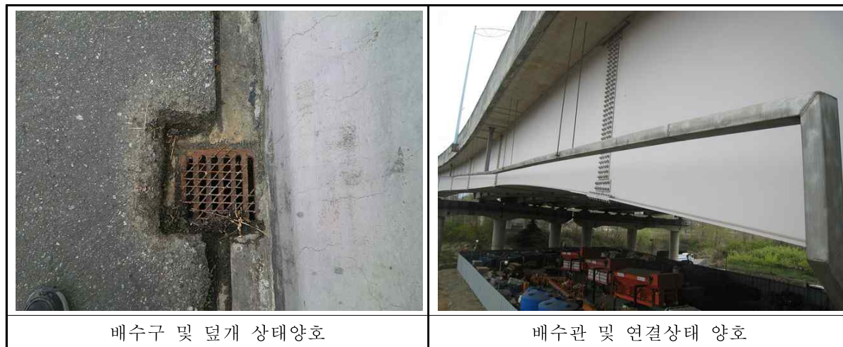
&lt;표 3.24&gt; 범물방향 배수시설 외관조사 결과
