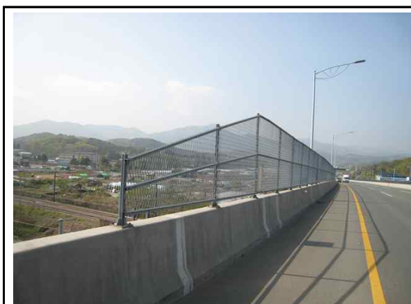
외측 방호벽 및 오물투척 방지망 전경
