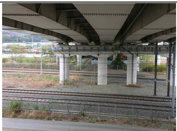
교각 P4 전경
