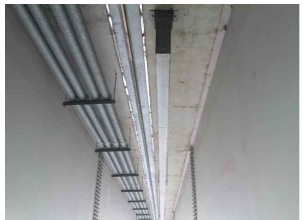
바닥판하면 캔틸레버부 전경(내측)
