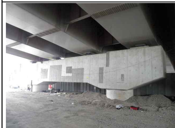
교각 P1 전경
