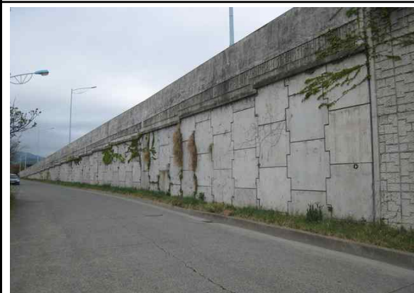
A1 날개벽측 판넬형옹벽 상태양호
