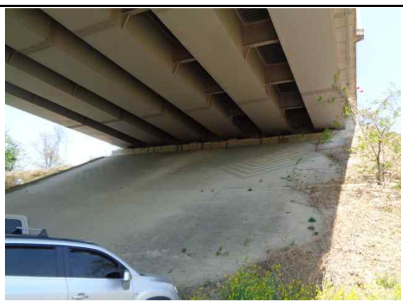
교대 A2 전경
