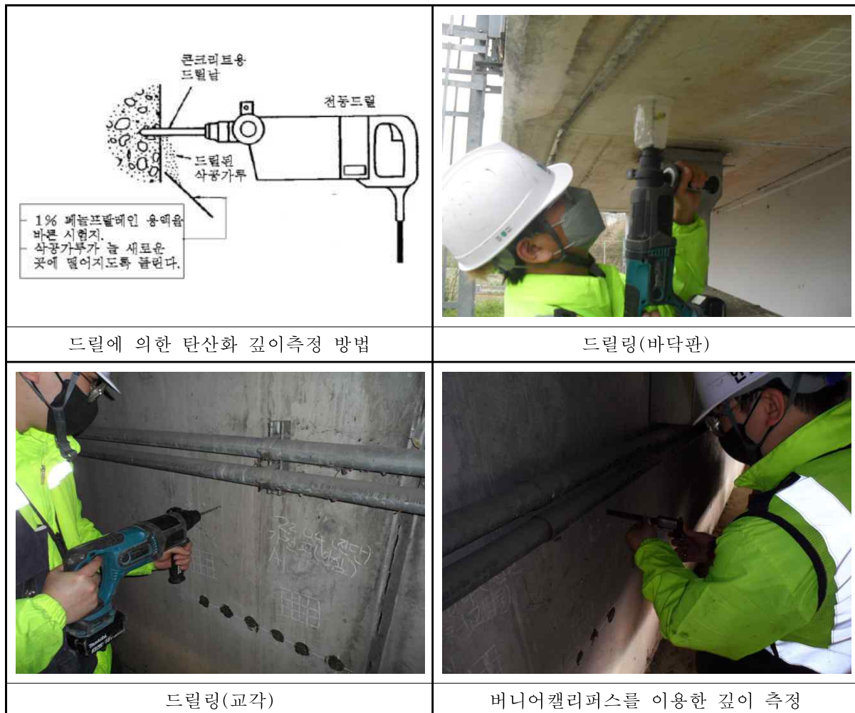
<그림 3.12> 드릴에 의한 탄산화 깊이 측정
