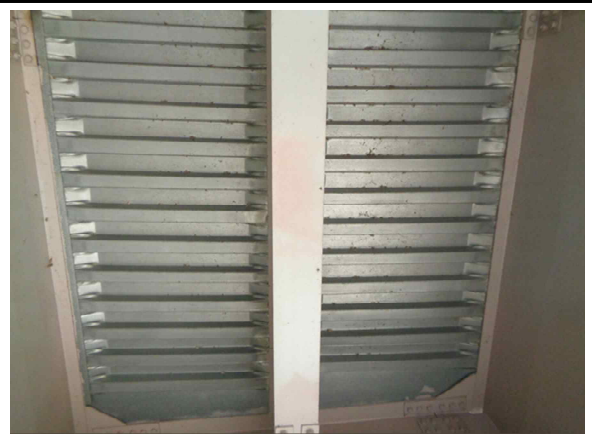
바닥판하면 데크플레이트 전경
