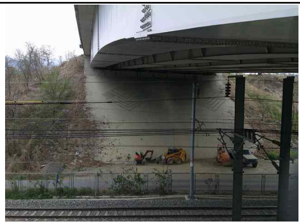
교대 A2 전경
