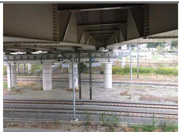
교각 P4 전경
