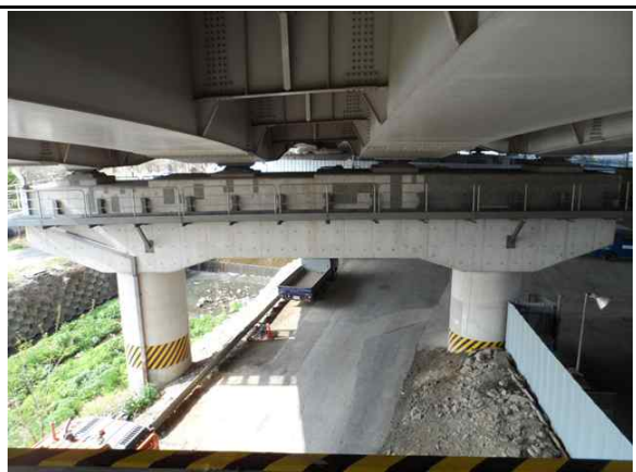
교각 P2 전경
