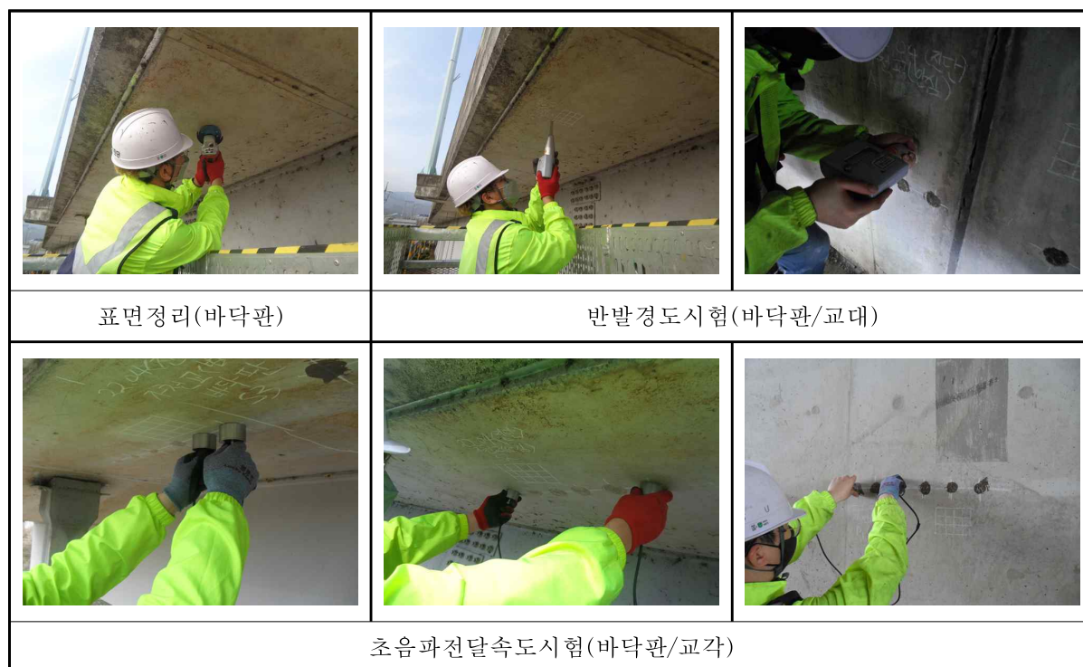
<그림 3.7> 콘크리트 강도조사
