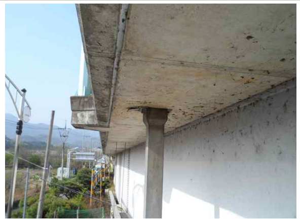
바닥판하면 캔틸레버부 전경(외측)
