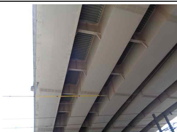
거더 외부(S5) 전경
