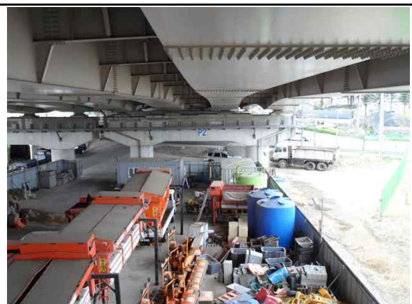
교각 P2 전경
