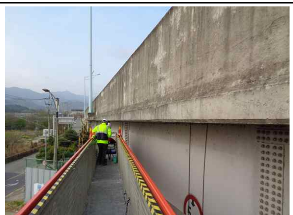
방호벽 외측 전경
